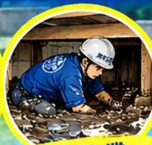
床下作業 (泥出し)
