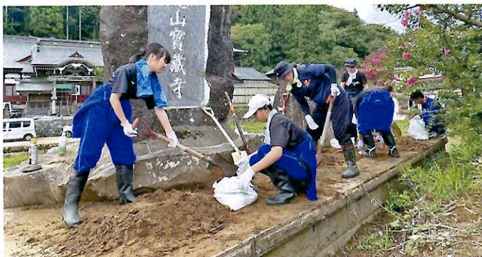
境内の汚泥をかき出し、袋詰め
