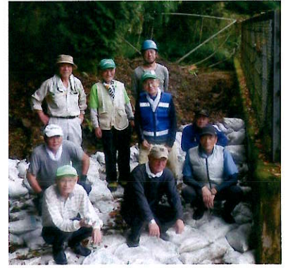
700袋も積み上げた土のうで一息
