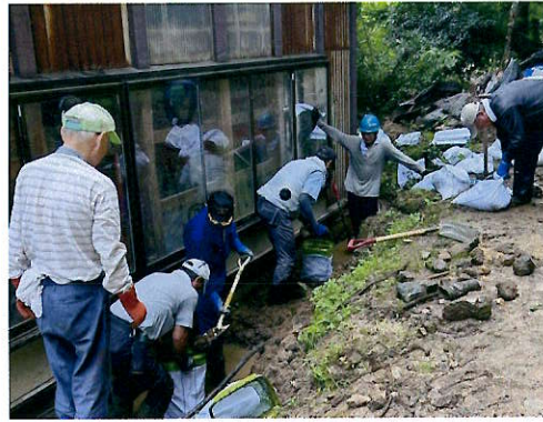
稲倉水路の側溝泥上げ作業
