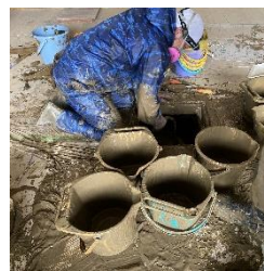
床下に潜っての泥出し作業
