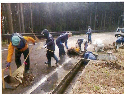
▲落ち葉で詰まった側溝を清掃
