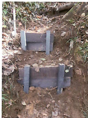
▲崩れた階段を修復
