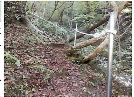
▲鋼管杭とロープの交換
