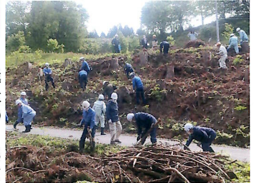
▲急斜面の作業に汗まみれ
