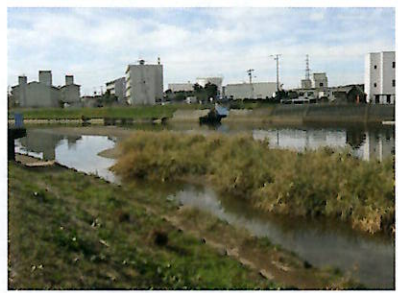
堆積土砂と繁茂した草
